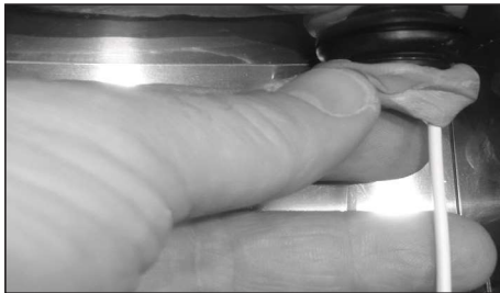
10. Die Bohrung innen mit Spachtelmasse verschließen.
