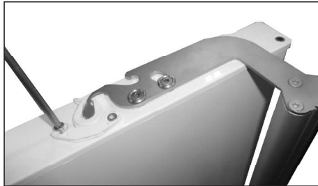
31. Auf der gegenwärtigen Türunterseite die beiden Schrauben vom Türschließer entfernen (mit Torx-Werkzeug der Größe 20).
