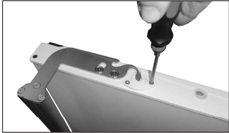
37. Die beiden Schrauben wieder anbringen, um den Türschließer zu fixieren.
